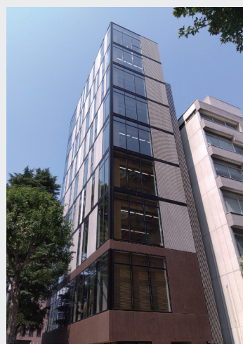
木造×鉄骨のハイブリッド構造、9階建てのオフィスビル「KiGi AKIHABARA」
