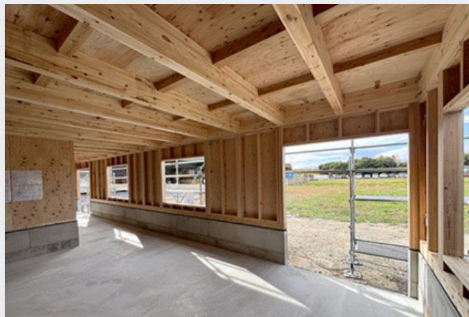
長谷川萬治商店の館林工場の敷地内に、間柱材やその合わせ柱だけで構成する事務所棟の建設を進めている
